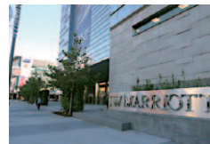
最近オープンするリッツ・カールトンは、このようにJWマリオットとのコラボレーションが多い。ちなみに双方は同じ番地を共有している
