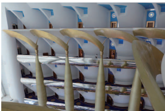
純金の金箔で仕上げた太い柱が何本も立つアトリウムの客室廊下部分。デュプレックス・スタイルのため各フロアは2階分の高さがある
